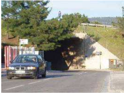
Manque de visibilité au niveau du pont - Av du Serpolet
